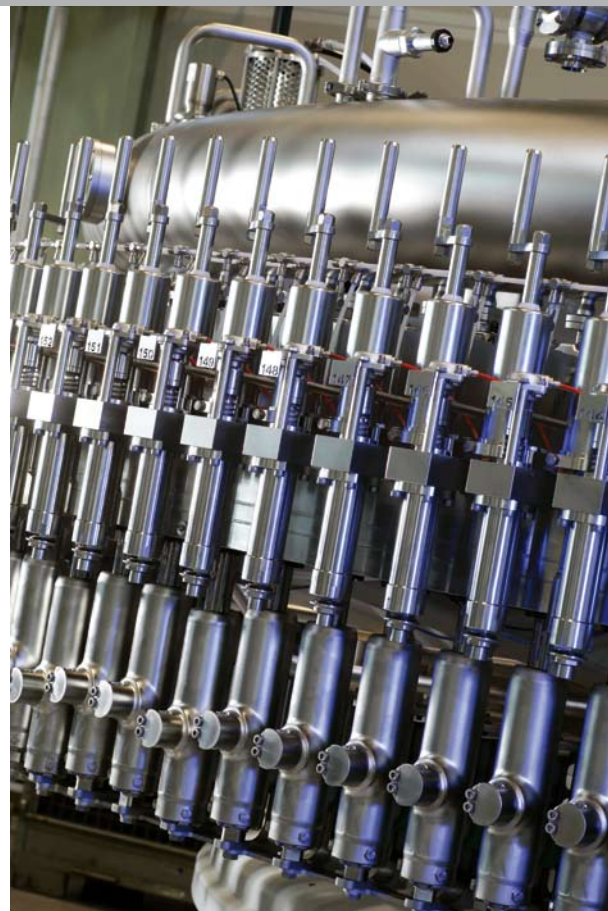
Válvulas en el carrusel de la llenadora Volumetric VODM-PET
